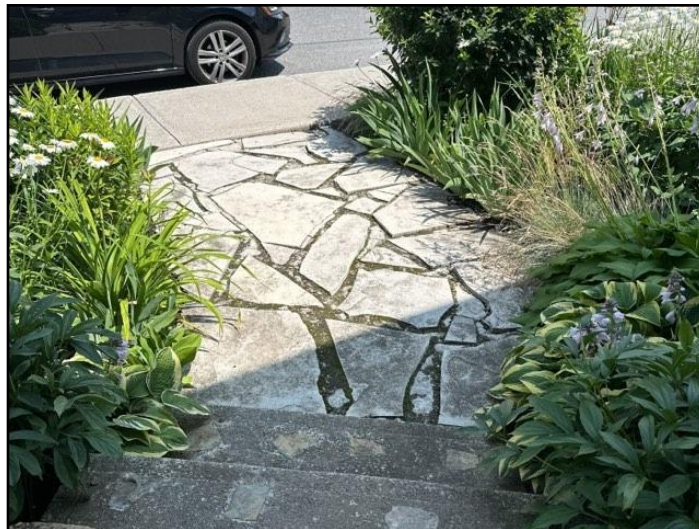
62. Uneven (trip hazard)
