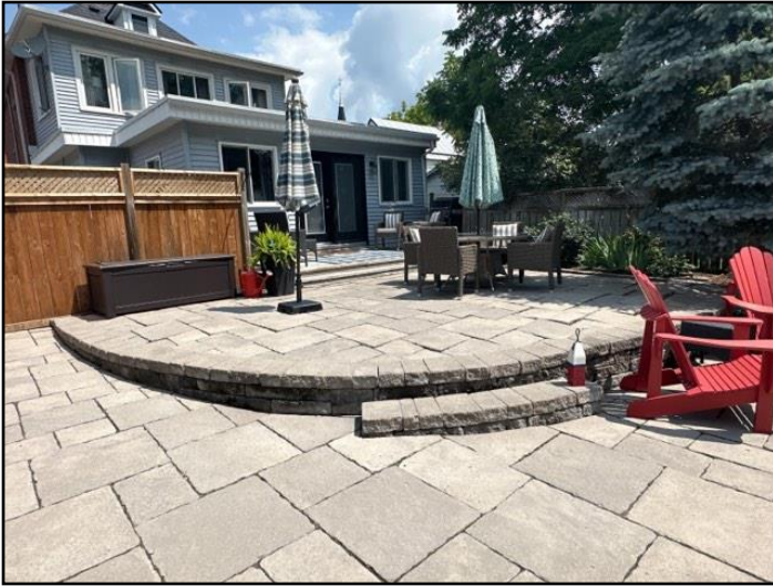
67. Uneven (trip hazard)
